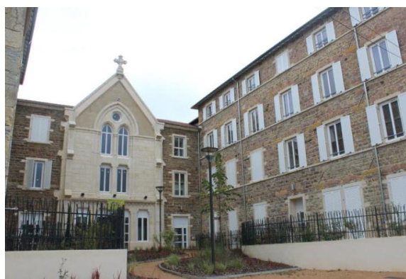
Ancienne maison de retraite du Margaret reconvertie en logements à Tarare (photo Benoit Mouget/le Progrès)
